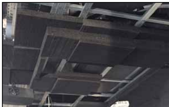
Soffitto realizzato con B-FLEX NR spelato agganciato su struttura in acciaio
