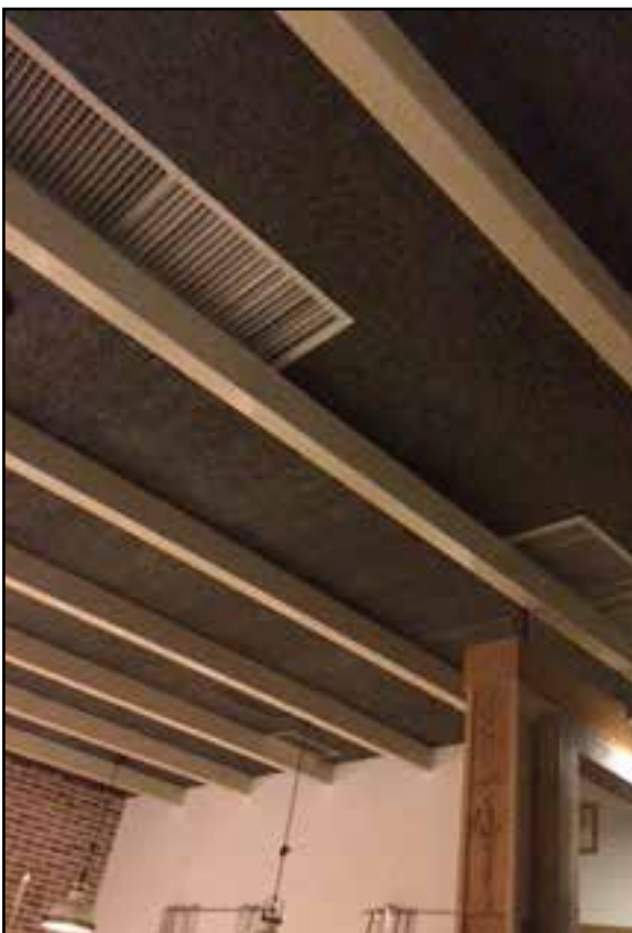
Soffitto realizzato con B-FLEX NR spelato
