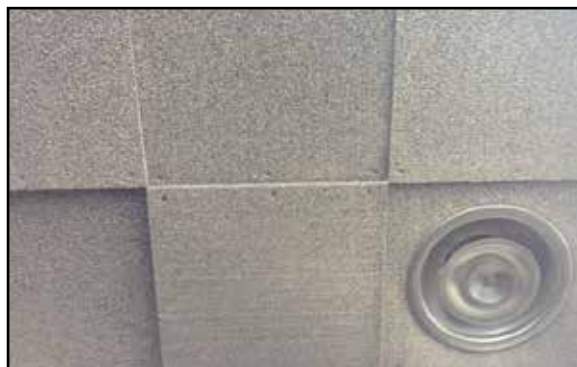
Soffitto realizzato con B-FLEX NR spelato
