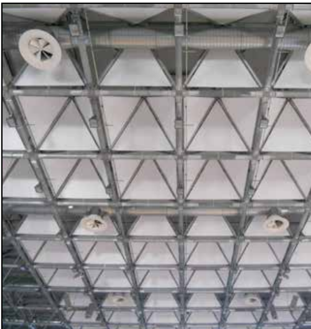
B-FLEX NR SPELATO SU UN LATO - Applicazione soffitto palazzetto dello sport
