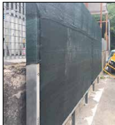
B-FLEX NR SPELATO UN LATO applicazione barriera acustica tra siti operativi
